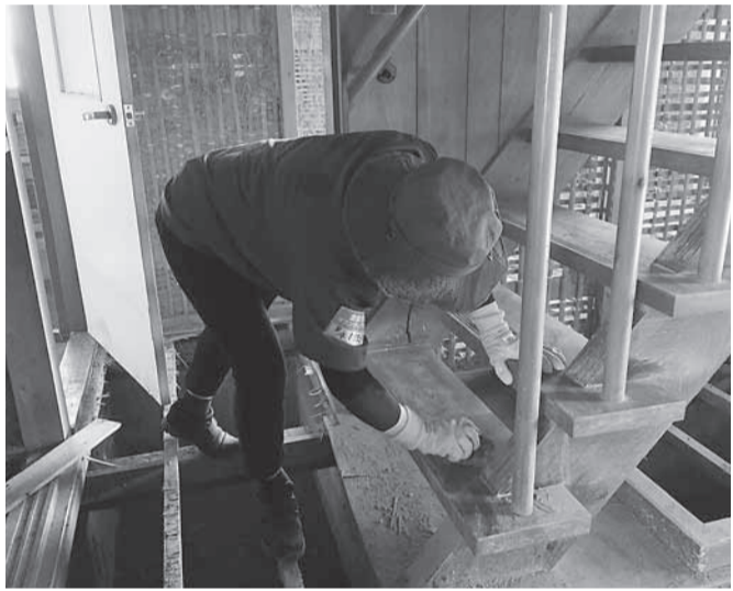
泥だらけになった階段の掃除
