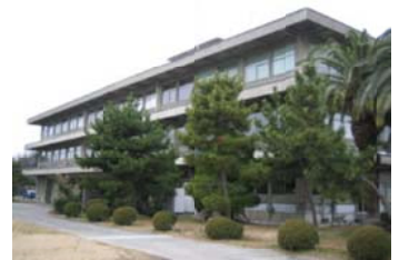
先端科学イノベーションセンター研究センター棟
